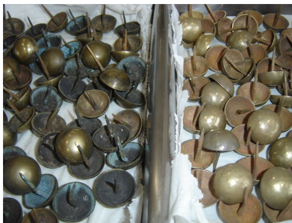
Pormenores, antes e depois, da fase de limpeza da corrosão dos balmazes em bronze.
